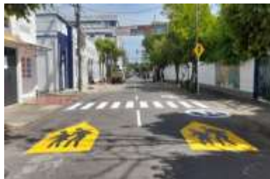
Señalización horizontal Carrera 15 entre calles 50 y 51 I.E. Central Integrada
